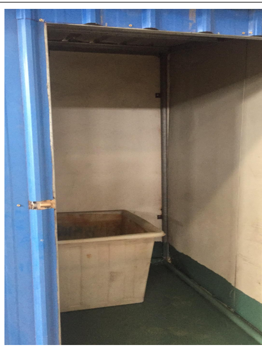
危险固废暂存场防腐防渗处理，设置托盘
